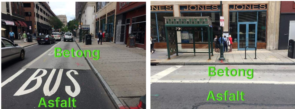
Figur 4. Exempel på fog mellan asfalt och betong på busstation. Källa: Jim Saksa, PlanPhilly, https://why.org/articles/streetsplainer-what-s-with-those-concrete-pads-in-front-of-bus-stops/ .
