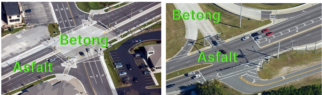
Figur 5. Exempel på fog mellan asfalt och betong på motorvägar. Källa: Mark Petersen, Ayresassociates.
