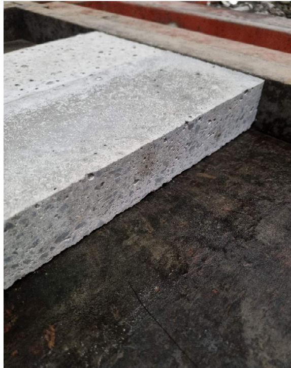
Figur 19. Exempel på placering av betongplattor före produktion av fogar. Foto: Patryk Witkiewicz.
