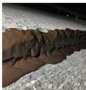
Figur 13. Sealflex© efter applicering. Källa: https://infracare.se/skarv-ytforsegling/infraroad-sealflex .
